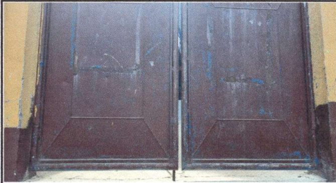
Foto1: Sustrucion de porton de metal
