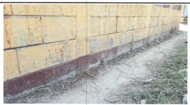
Foto 6: Pintura en muro Exterior e Interior
