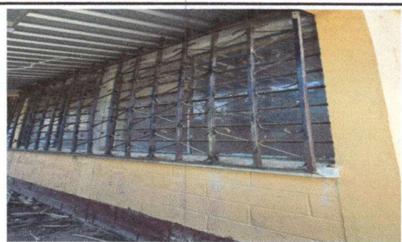
Foto 4: Sustrucion de Balcon de metal
