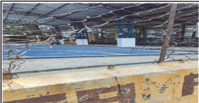
Foto 3: Reparacion de muro perimetral de Block
