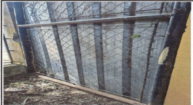
Foto 2: sustitucion de puerta
